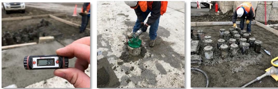
Ejecución de Ensayos al Hormigón Fresco y Elaboración de Probetas
