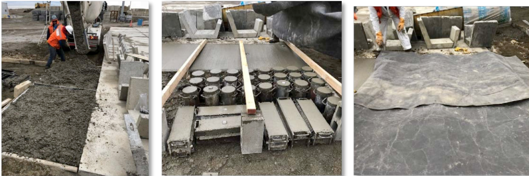
Confección de Cancha de Prueba y posterior Protección de un sector
