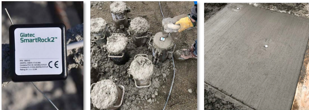
Colocación de sensores en probetas y pavimento
